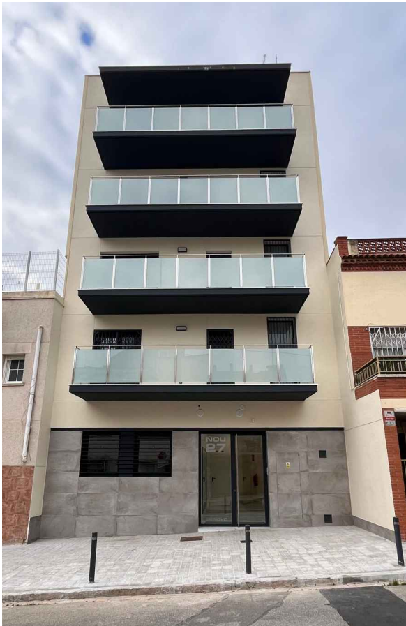
Façana c. Nou
